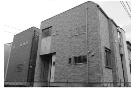
A・B号棟 外観
